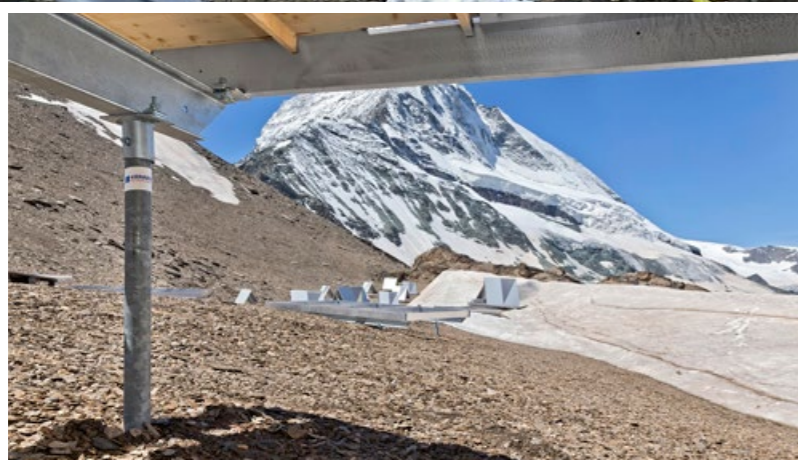
MATTERHORN Auch in extremster Umgebung bewähren sich Schraubfundamente.
